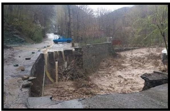
وجود راههای روستایی در بستر اصلی رودخانه ها و عدم رعایت استانداردها در ساخت سازه های مواصلاتی نظیر پل و راههای ارتباطی
